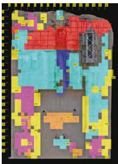
5A, 5B e 5C. Un esempio di identificazione delle difettosità in un quadrante di una pila attraverso ADD_B® e visualizzazione dei difetti nel modello 3D
