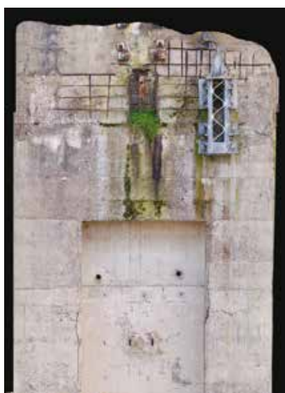
5A, 5B e 5C. Un esempio di identificazione delle difettosità in un quadrante di una pila attraverso ADD_B® e visualizzazione dei difetti nel modello 3D
