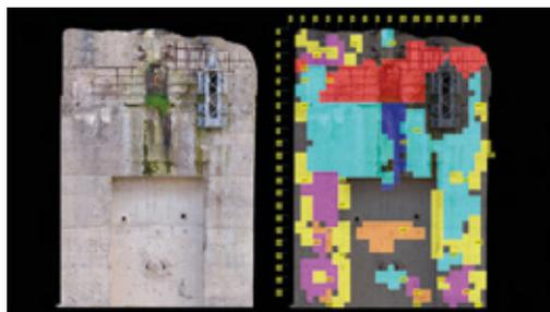
Utilizzo dell'Intelligenza Artificiale per l'identificazione, la classificazione, la quantificazione dei difetti e la valutazione dell'indice di vulnerabilità strutturale, attraverso il **software ADD\_B© - Automated Defect Detection Bridge** di **identificazione automatica dei difetti**.
