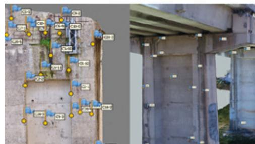
**Catalogazione fotografica di dettaglio** degli elementi strutturali e **georeferenziazione** dei singoli difetti sul **modello digitale gemello 3D** dell'opera.
