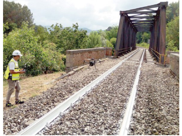
Tecnologie per la sicurezza. Ispezione con un drone lungo la rete ferroviaria
