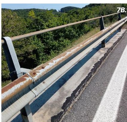
7A e 7B. Esempio di dispositivo con presenza di ossidazione
